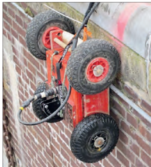
Рис. 7. Обнаружение трещин, пустот и каналов внутри каменных стен с помощью георадара
