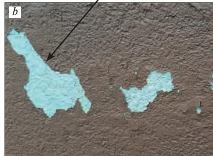
**Рис. 2.** Отслоение акриловой краски с поверхности штукатурного покрытия в комплексе «Европа» (*a*); фрагмент отслаивающейся краски (*b*)
