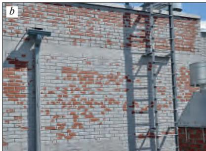
**Рис. 1.** Отслоение акриловой краски на парапетах кирпичных зданий в г. Ижевске: *a* – комплекс «Максима»; *b* – комплекс «Горизонты»
