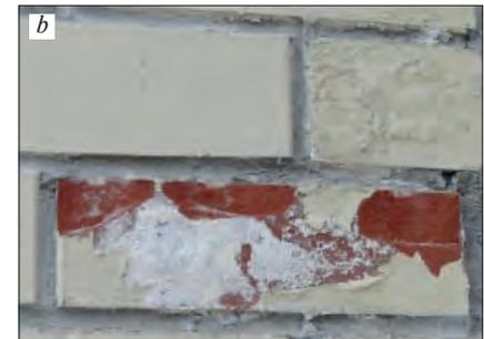
**Рис. 3.** Общий вид разрушающегося полимерного покрытия на кирпичной кладке (*a*); отслоение полимерного покрытия на поверхности кирпича вследствие высолообразования (*b*)
