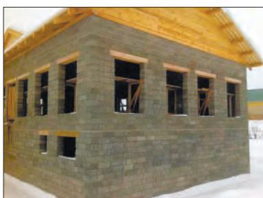
**Рис. 3.** Внешний вид коробки здания, построенной с использованием блоков (рис. 2, *a*) с льняным наполнителем ([https://build2last.ru/megacat/portfolio\\_detailed\\_img/2665/1556713227/0/dom-iz-arbolita/1.jpg](https://build2last.ru/megacat/portfolio_detailed_img/2665/1556713227/0/dom-iz-arbolita/1.jpg))
