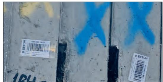
**Рис. 3.** Штрихкодирование в тело бетона
