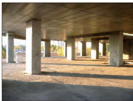
**Рис. 1.** Несущие конструкции стен, колонн и постнатяженных перекрытий пролетом 8 м здания «Gazoil Plaza» (Москва) из конструктивного легкого бетона фактических классов Bф45–Bф50
